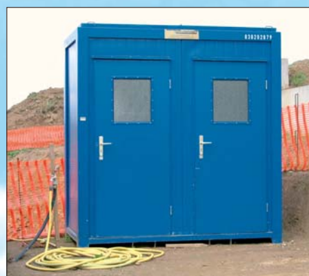
Prefabbricato modulare uso WC per un cantiere
